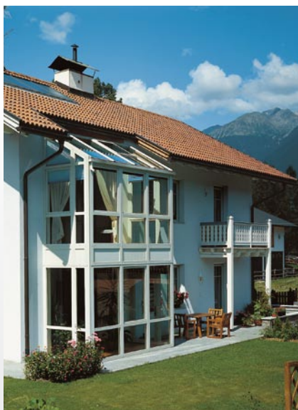
2-stöckiger Glasanbau mit Dacheinschnitt
